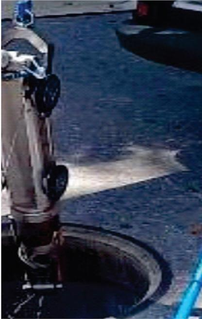
**Figura 2. Robot fresador presentado en la boca de la alcantarilla**
