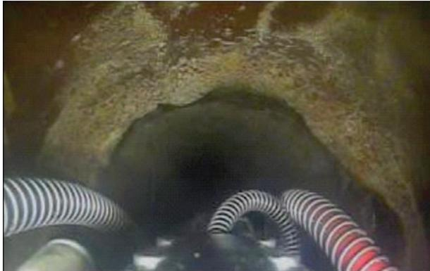
**Figura 12. Estructuras surgidas en el interior de la tubería**
