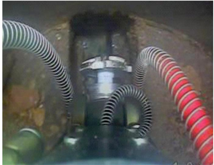
**Figura 3. Robot fresador presentado en la boca de la tubería**
